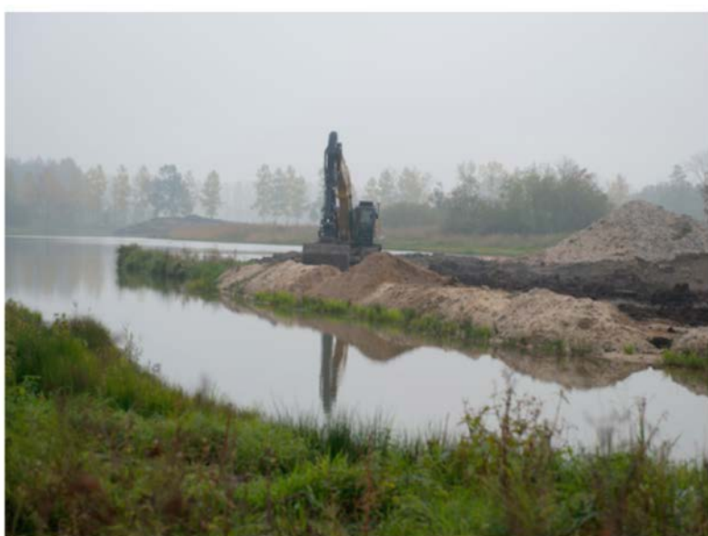
Werkzaamheden aan de Oude Maasarm
