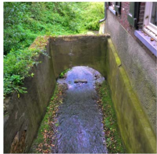
Houthuizer Watermolen: kom van het schoepenrad
