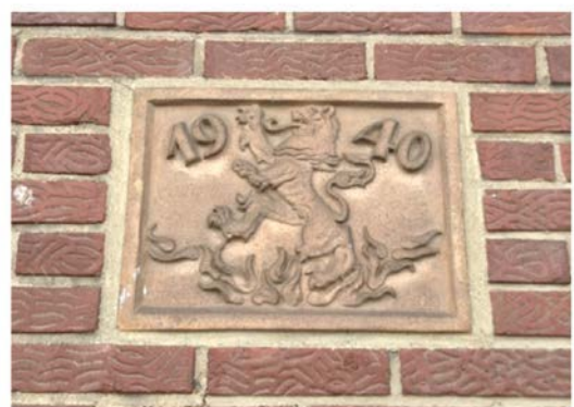
Gevelsteen wederopbouwboerderij Tacken
