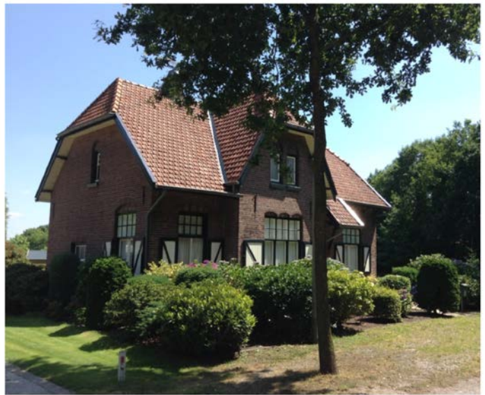
Het voormalige postkantoor
